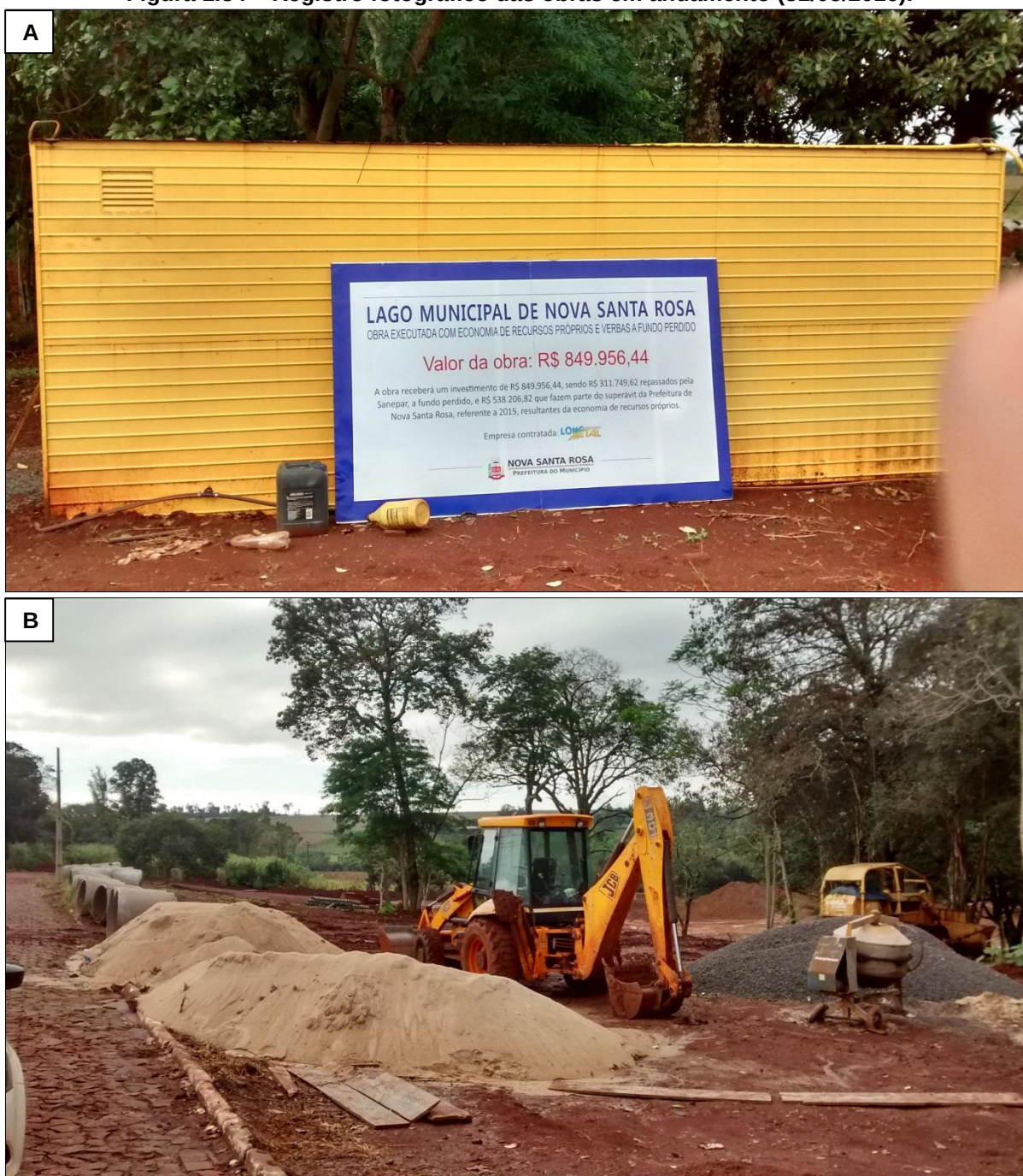
Figura 1.34 – Registro fotográfico das obras em andamento (31/05/2016).
