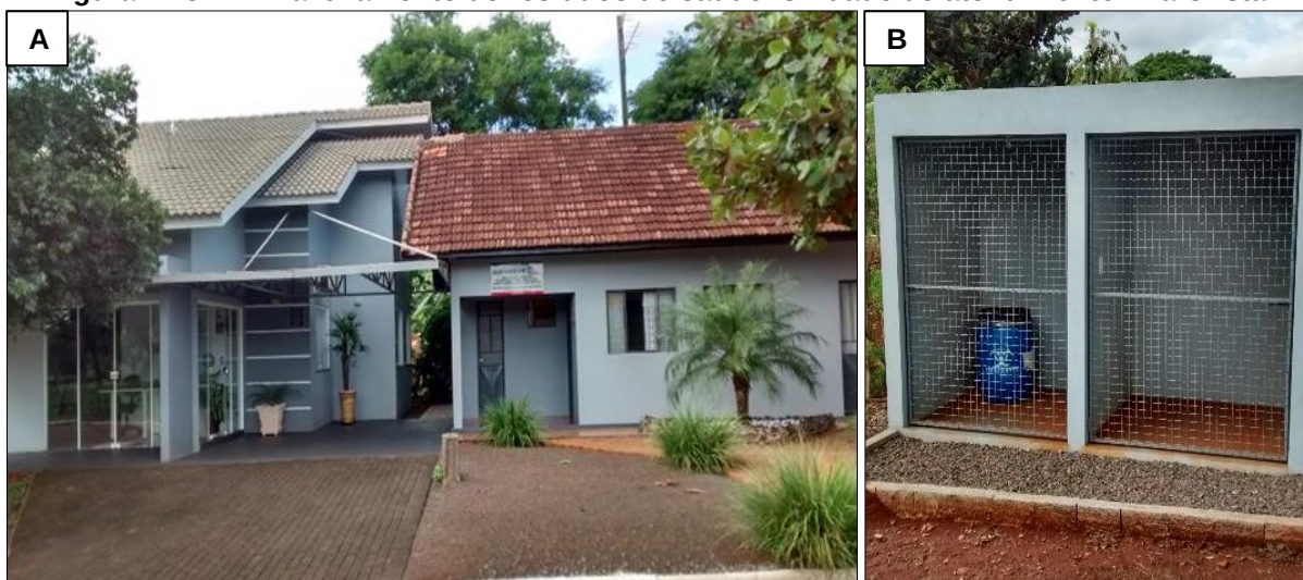
Figura 1.43 – Armazenamento de resíduos de saúde. Unidade de atendimento Vila Cristal
