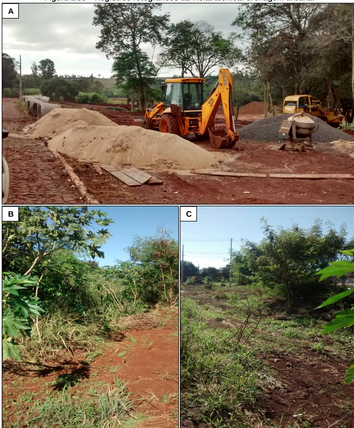
Figura 1.33 – Registros fotográficos da visita técnica: drenagem urbana.
