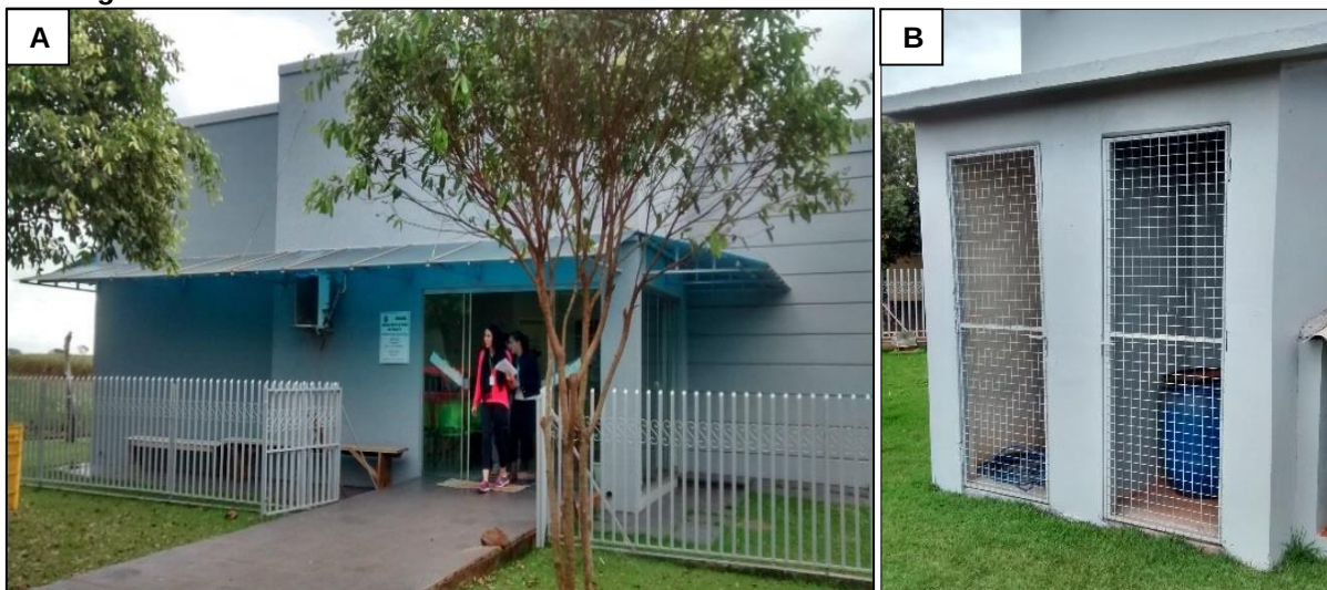
Figura 1.45 – Armazenamento de resíduos de saúde. Unidade Básica de Alto Santa Fé
