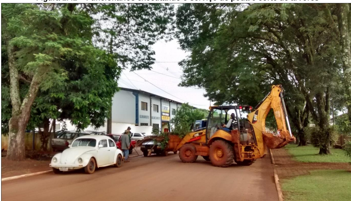
Figura 1.42 – Funcionários executando o serviço de poda e corte de árvores
