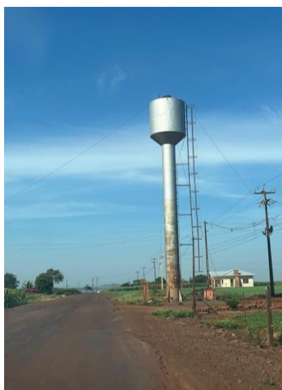
Figura 26 – Reservatório de água (Alto Santa Fé)
